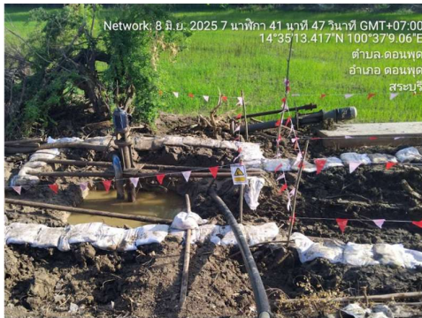
กิจกรรมการวางท่อด้วยวิธีเจาะลอด (HDD)
