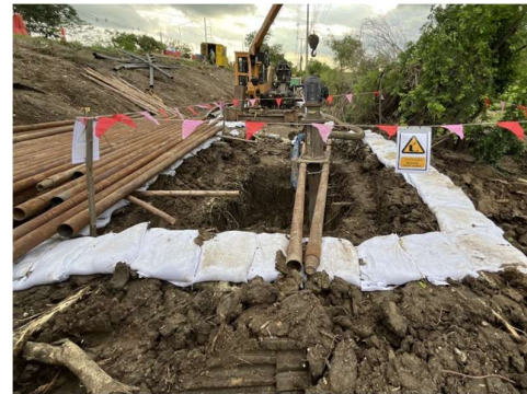
กิจกรรมการวางท่อด้วยวิธีเจาะลอด (HDD)
